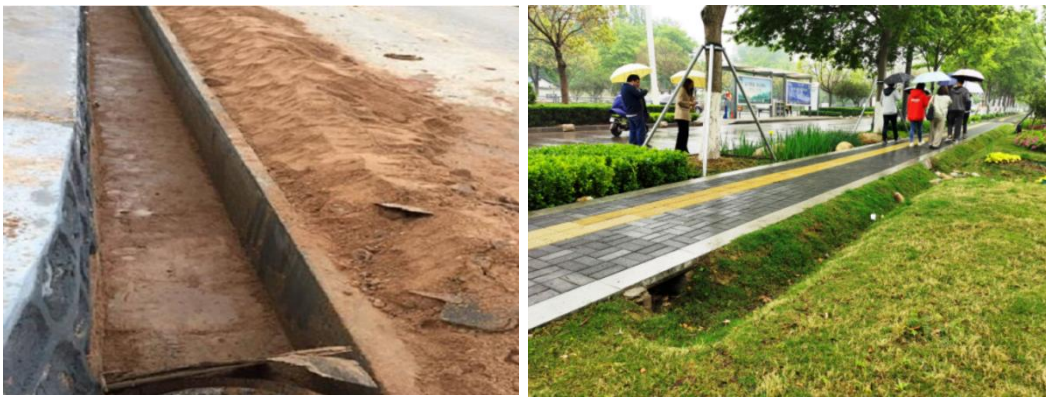
图 6.4-2 临时排水沟（左）与植草沟（右）
