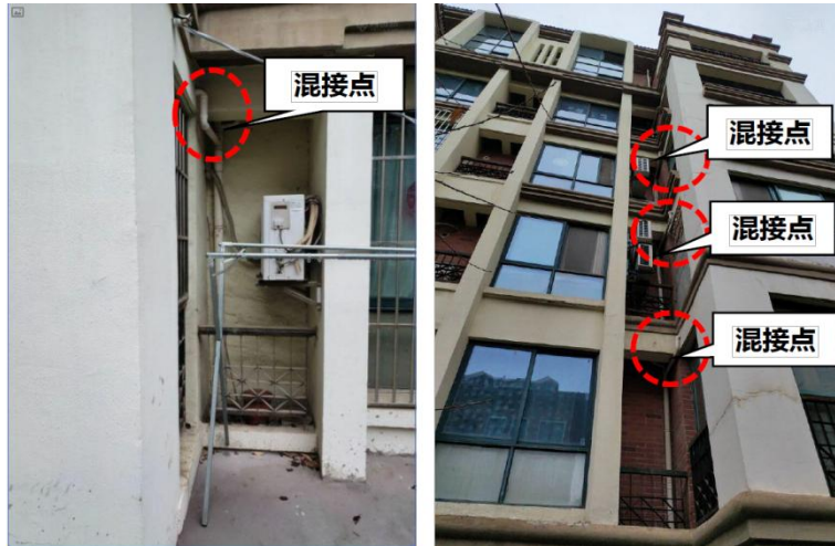
改造前雨污混接示意图
