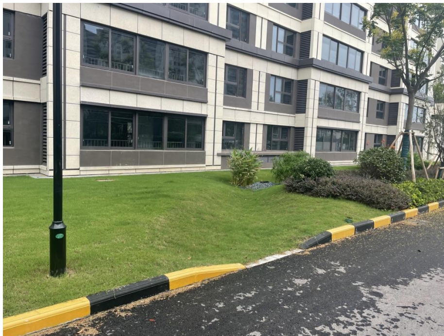
图 6.3-33 开口路缘石做法示意图（地块类项目）
