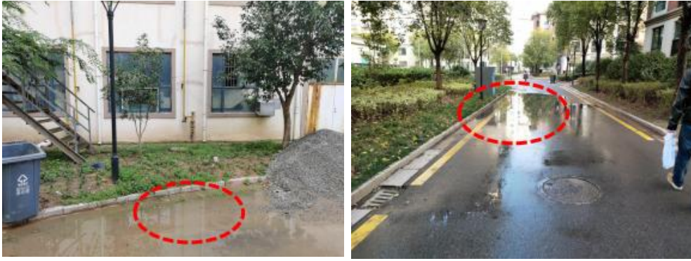
改造前路面积水照片
