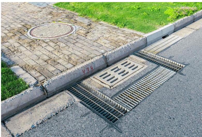
图 6.3-36 雨水口截流改造做法照片
