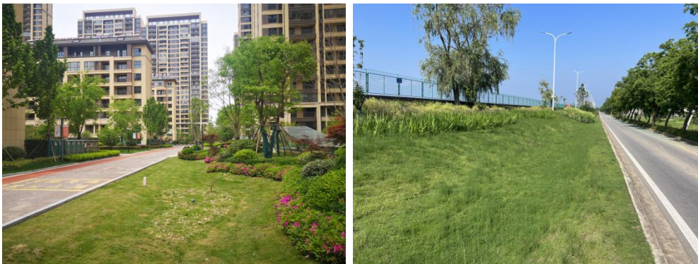
图 6.3-18 盆地式下沉式绿地（左）与草坡式下沉式绿地（右）示意图
