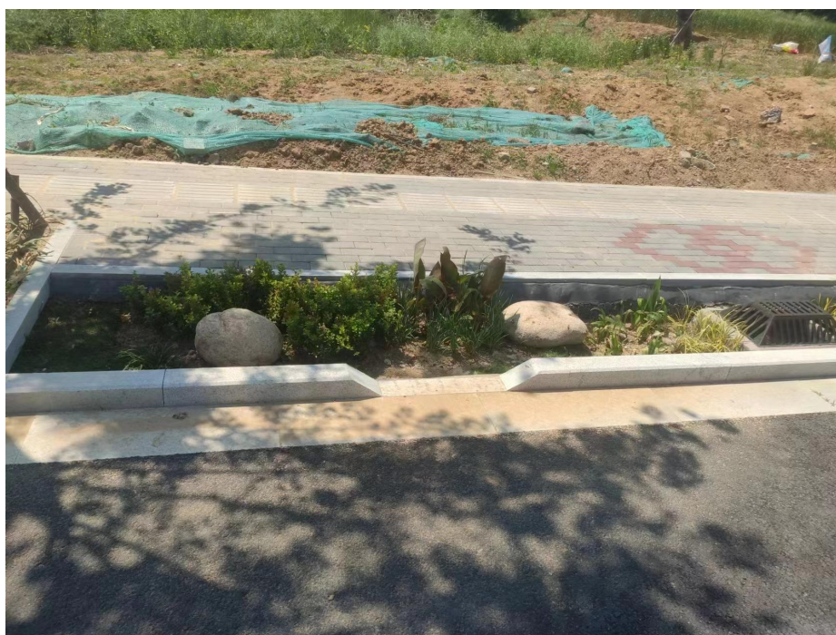
图 6.3-34 开口路缘石做法示意图（市政类项目）
