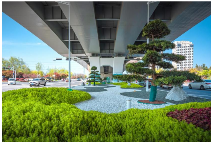
高架桥雨落管断接照片
